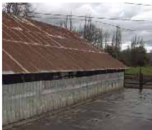
Foto 1.3. Techos sin canalización independiente de aguas lluvia.
