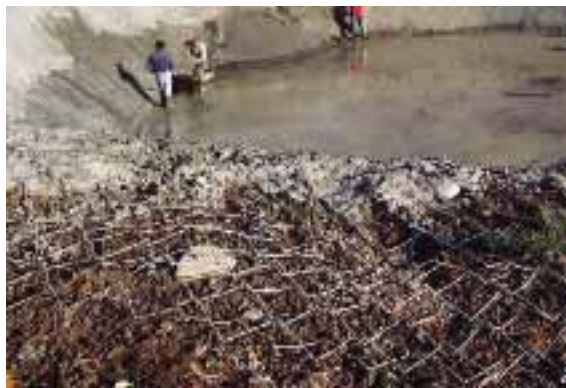
Foto 4.10. Sistema de sellado con mallas y cemento estucado.
