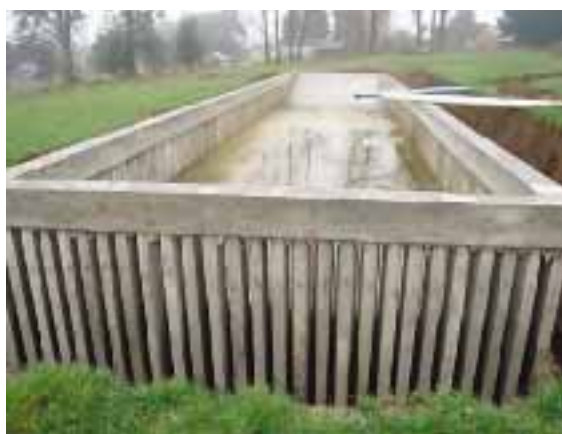
Foto 4.7. Pozo con separador de columnas.
