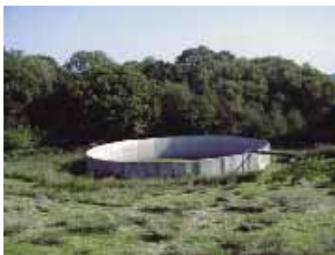
Foto 1.5. La superficie expuesta del pozo purinero recibe directamente aguas lluvia, por lo tanto a mayor superficie mayor cantidad de agua que recibe por esta vía.
